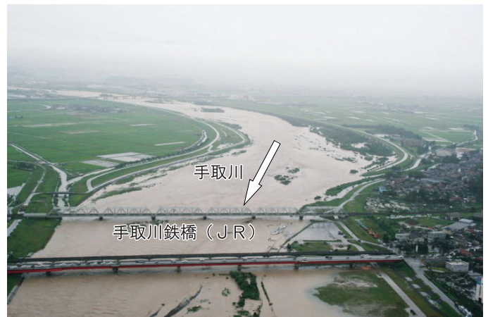
手取川出水状況(河口付近) 平成18年7月19日8時撮影
