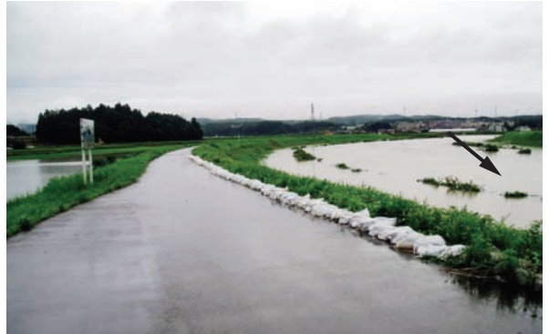
土のう積み工状況 梯川8.2k右岸 L=40m (小松市古府町)
