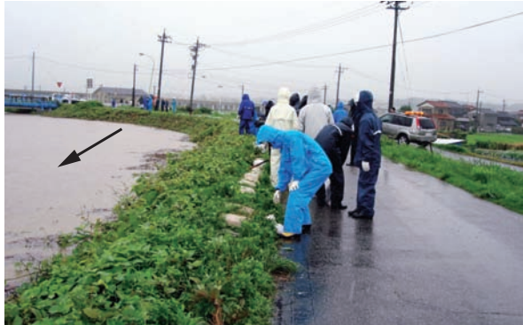
土のう積み工状況 梯川6.8k左岸 L=150m (小松市金屋町)
