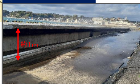
岸壁背後の沈下
