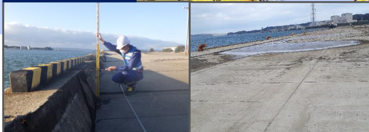
岸壁の沈下
