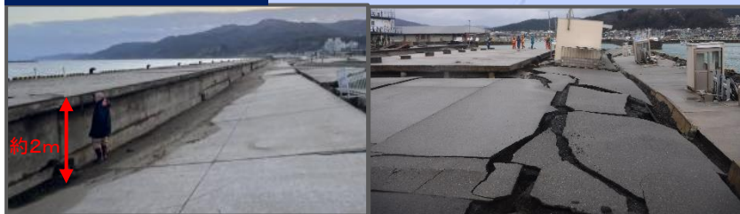
岸壁背後の沈下
