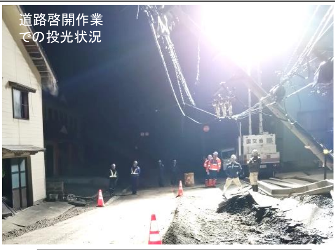
道路啓開作業での投光状況 照明車による24時間体制の復旧支援
