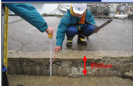
岸壁背後の沈下
