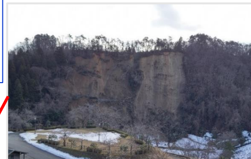
貯水池周辺斜面小規模崩落 (1/5撮影)
