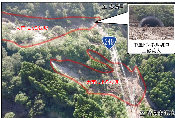
① 中屋トンネル付近 (輪島市門前町西円山)
