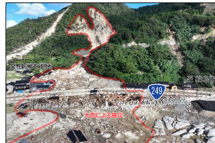
③ 逢坂トンネル付近 (珠洲市仁江町)
