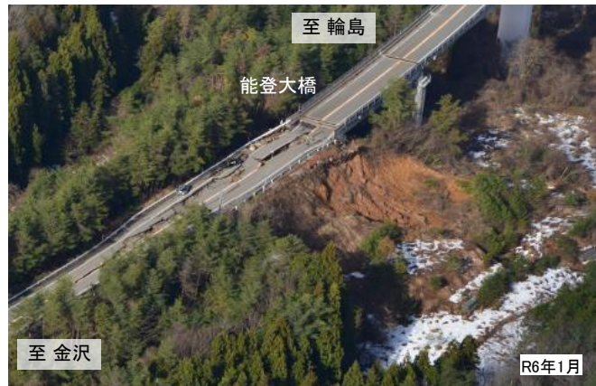
写真:被災直後の能登大橋付近の崩落状況
