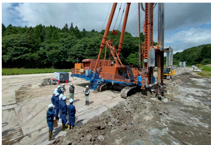
能越道 深層混合ICT施工
