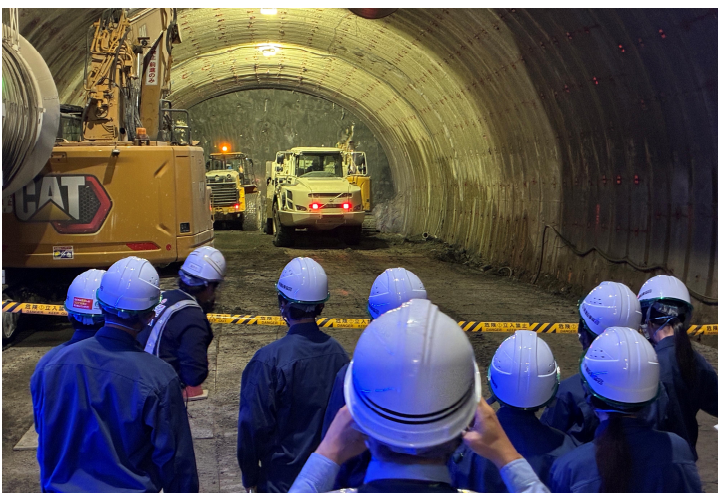
森本TN 掘削土搬出状況
