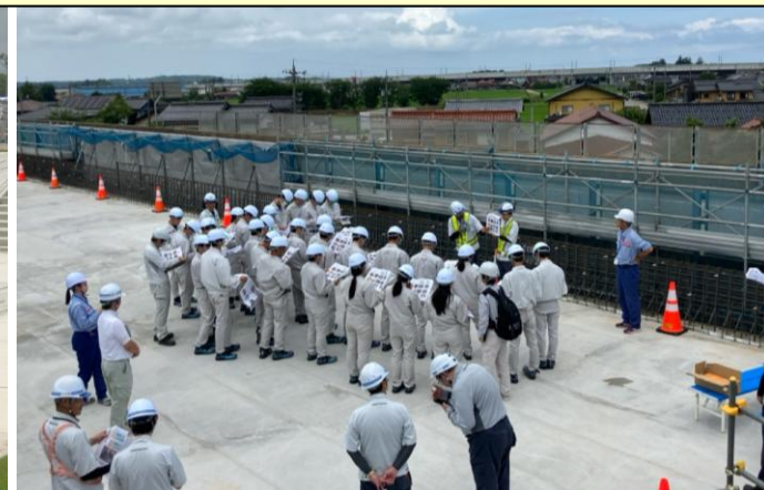
国道8号小松バイパス二ツ梨跨道橋 上部工事現場見学
