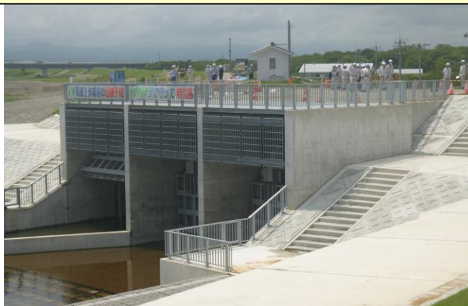
熊田川樋門工事現場見学
