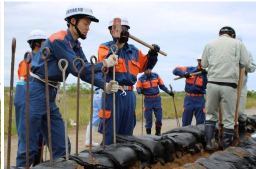
積み土のう工
