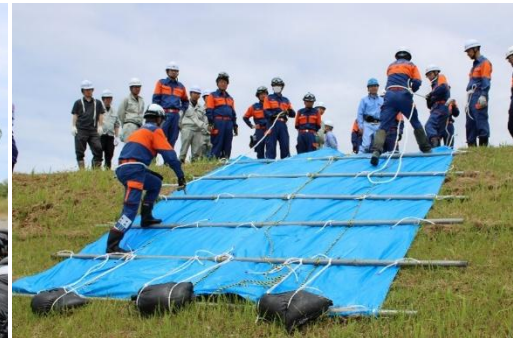
シート張り工
