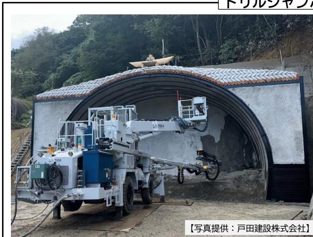
ドリルジャンボによる掘削の様子
