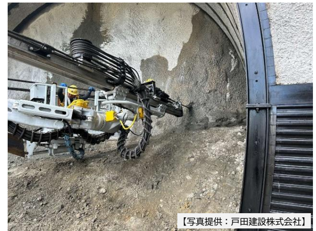
ドリルジャンボによる掘削の様子
