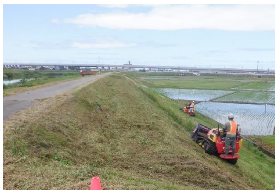
除草作業状況
