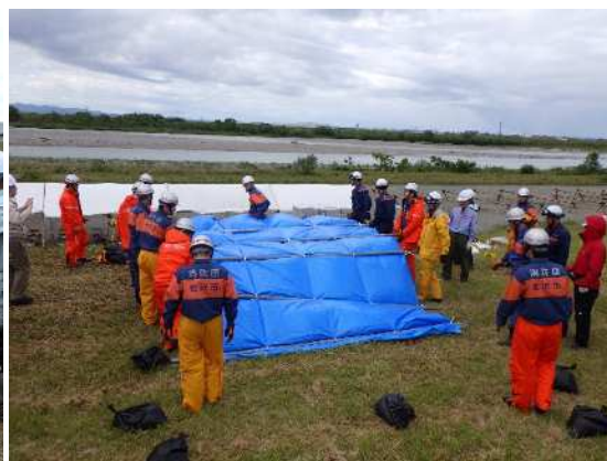
シート張り工
