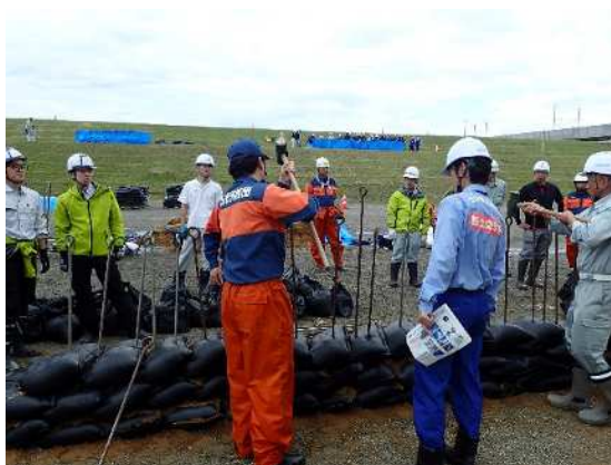
積み土のう工
