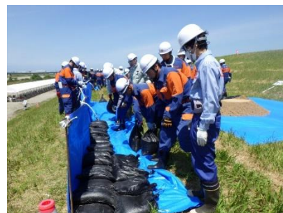
改良積土のう工
