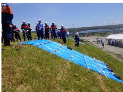
シート張り工
