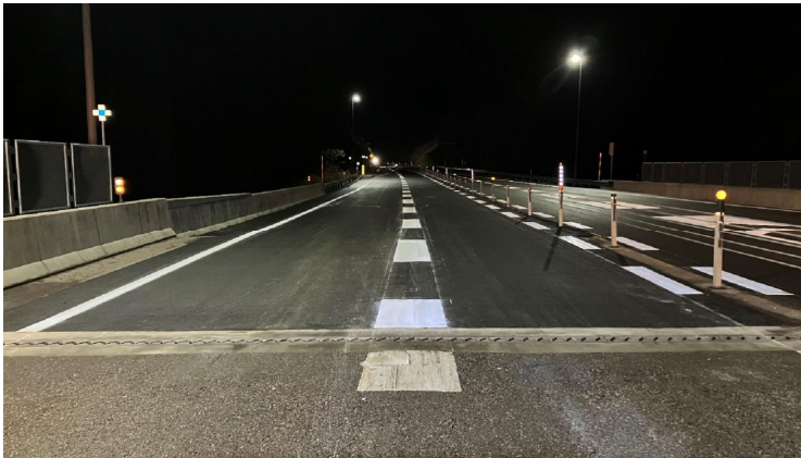
舗装の補修状況
