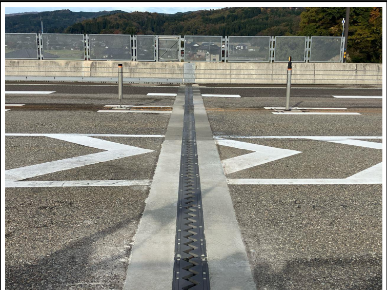
橋梁の補修状況
