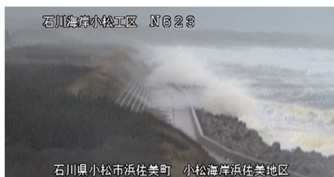
令和 4 年 12 月 14 日 9:00 頃 冬季風浪による越波の様子（小松地区 CCTV カメラ画像）
