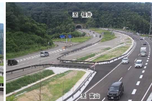
写真②: 神谷内IC付近車両走行状況
