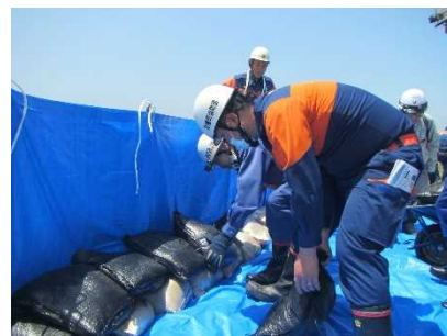
改良積土のう工
