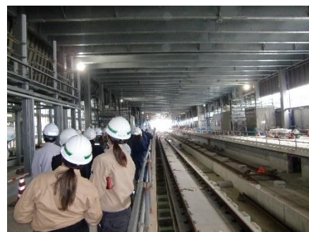
昨年の百万石小町「結」見学会の様子 (北陸新幹線小松駅舎工事現場)
