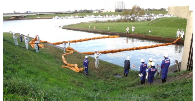
オイルフェンス設置
