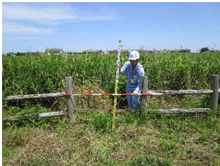
6 月 26 日 木柵損傷（梯川）
