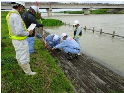
昨年の点検状況(梯川)
