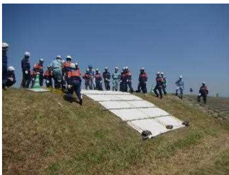
シート張り工
