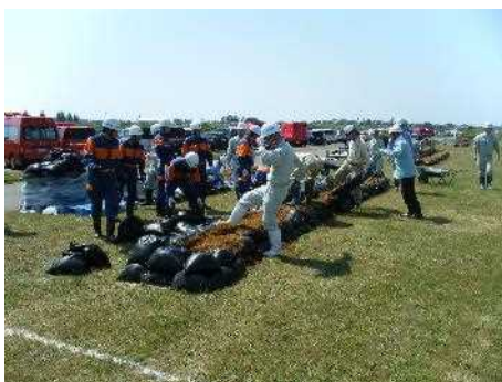
積み土のう工
