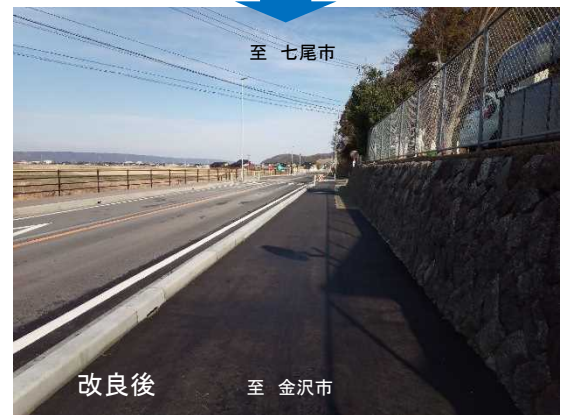
完成した菅原歩道
