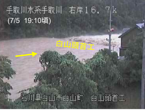
手取川水系手取川 右岸16.7k (7/5 19:10頃) 白山頭首工 石川県白山市白山町 白山頭首工
