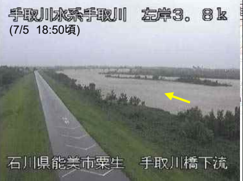
手取川水系手取川 左岸3.8k (7/5 18:50頃) 石川県能美市栗生 手取川橋下流
