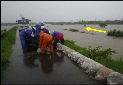
梯川左岸（佐々木町） 積み土のう工
