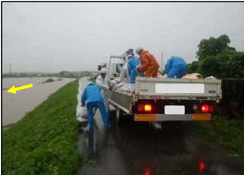
梯川左岸（佐々木町） 積み土のう工
