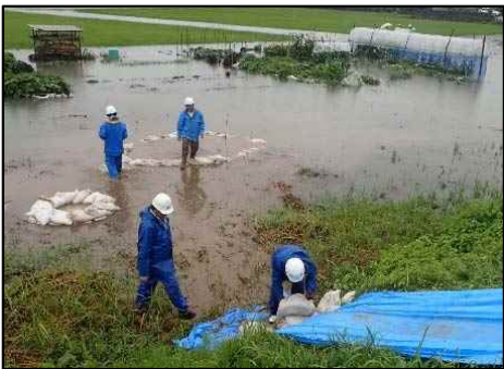
梯川左岸（荒木田町） 釜段工
