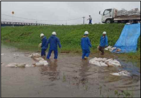
梯川左岸（荒木田町） 釜段工
