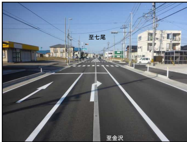
完成した木津中交差点
