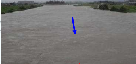
石田橋上流 2.0kp (8/8 14:30頃)
