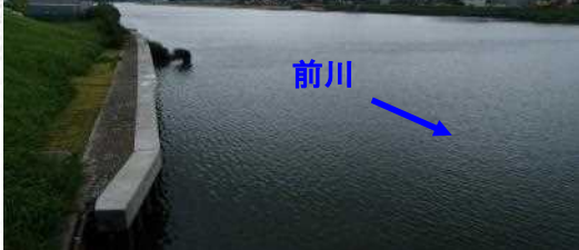
梯川逆水門上流 左岸1.0kp付近 (8/8 14:30頃)
