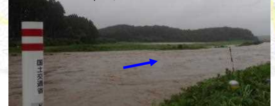
直轄上流端付近 右岸12.0kp (8/8 11:00頃)
