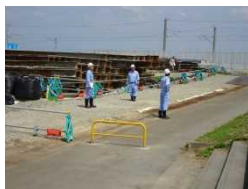
→是正措置完了
