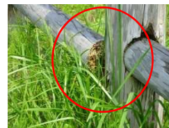
→是正措置完了
