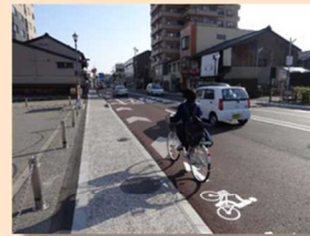
●自転車走行指導帯の設置(国道359号)
