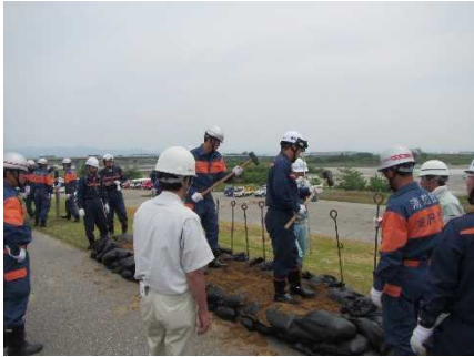
積み土のう工
