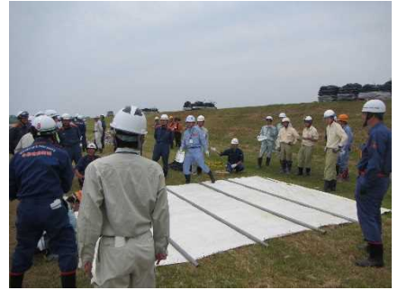
シート張り工
