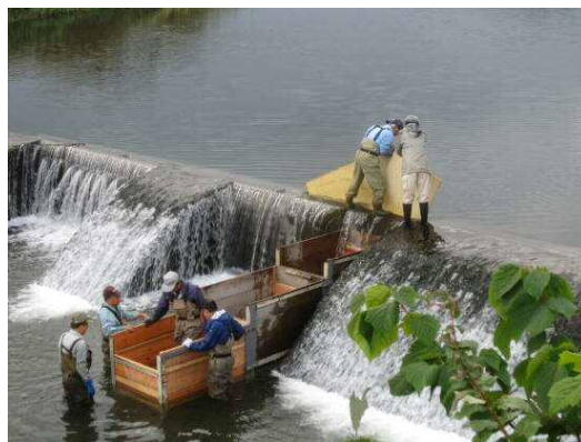
サケの魚道設置
