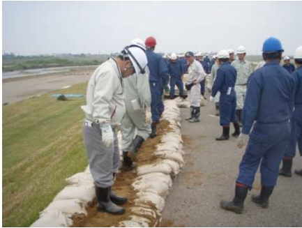
積み土のう工
