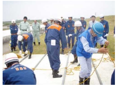
シート張り工
