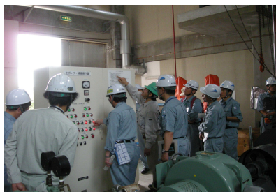
安産川排水機場での訓練状況
