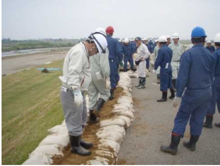
積み土のう工
