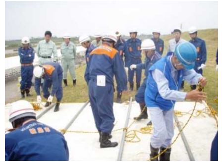
シート張り工
