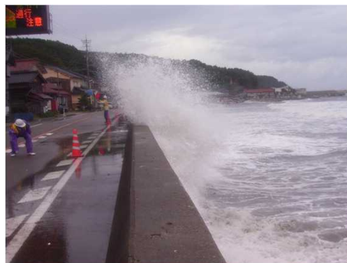
写真①：越波による通行規制 (七尾市大泊：平成16年8月20日発生)
