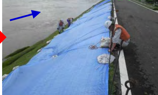
①梯川右岸5.7k付近のブルーシート設置状況
