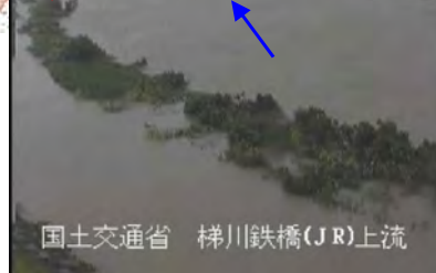
かがれおおれ 梯川鉄橋 (JR) 上流CCTV (左岸4.0k) (9/16 10:00頃)
