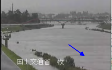
まき 牧CCTV (右岸2.3k) (9/16 10:30頃)
