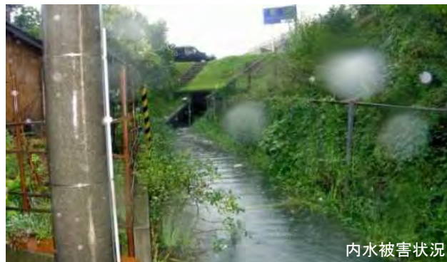
①宮田屋第二樋管
