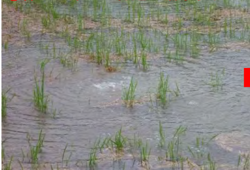
②梯川左岸9.6k付近の漏水状況
