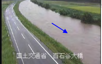
ひゃくごうりゅうてん 百石谷大橋CCTV (右岸11.4k) (9/16 8:40頃)
