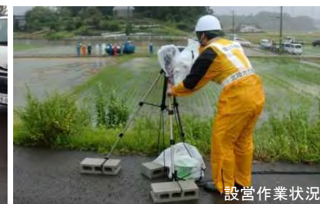
設営作業状況
