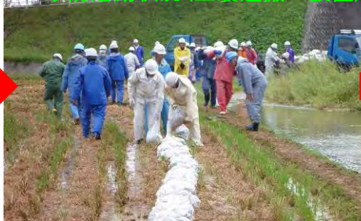
②梯川左岸9.6k付近の水防活動状況（土嚢運搬・設置）
