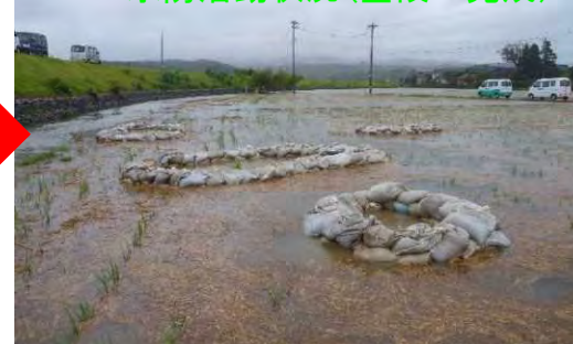
②梯川左岸9.6k付近の水防活動状況（釜段工完成）
