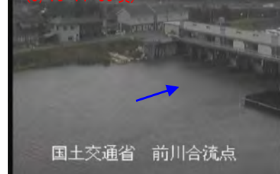
まえかわごうりゅうてん 前川合流点CCTV (左岸1.0k) (9/16 11:00頃)
