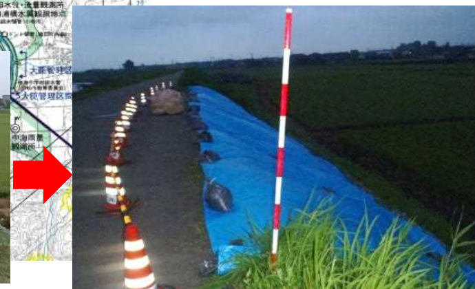
④梯川右岸8.4k付近の応急復旧
