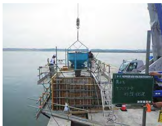
金沢港防砂堤 嵩上コンクリート打設状況
