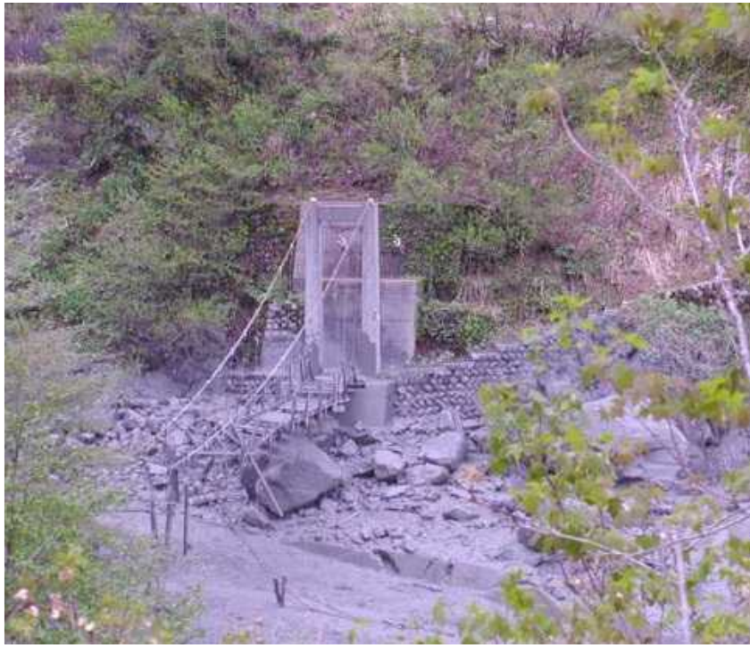
流された吊橋(H16.5.17)
