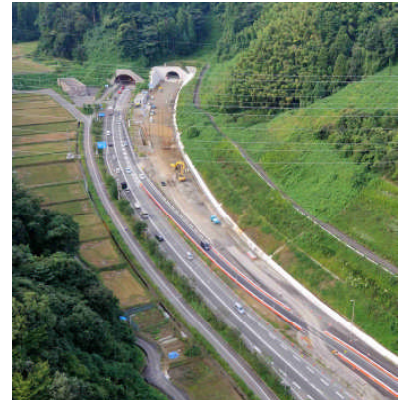
東長江より鈴見(卯辰トンネル)方面を望む
