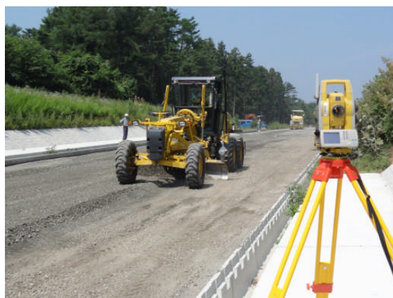
情報化施工による工事
