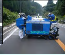
グルーピング工施工状況例
