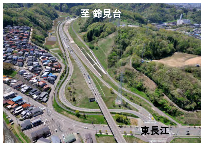
東長江交差点より卯辰トンネル方面を望む
