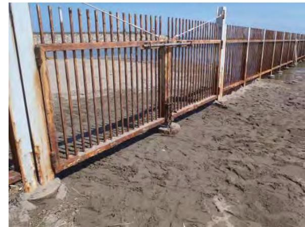
(水難事故が起きた場合、迅速に救助にあたれるよう大型離岸堤前の土砂を撤去し閉閉可能にする)
