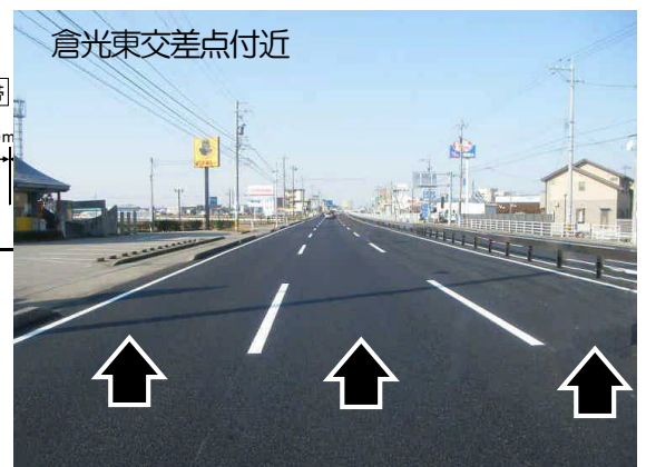
整備後 (金沢側より小松方向を望む)
