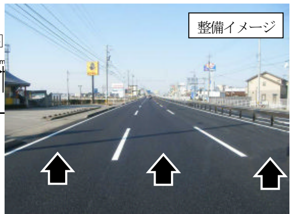
整備後 (金沢側より小松方向を望む)
