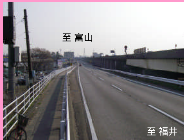
供用後状況(上り線)
