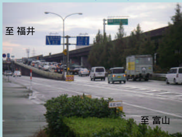
供用前状況(下り線)
