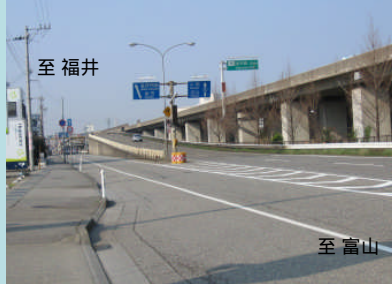
供用後状況(下り線)
