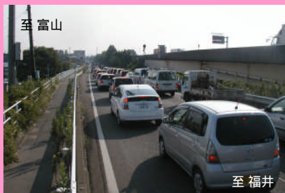
供用前状況(上り線)
