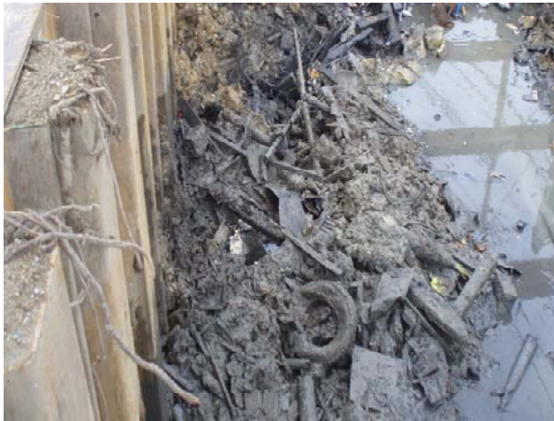
①掘削時の状況
