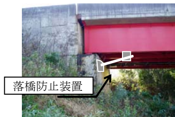
落橋防止装置設置箇所
