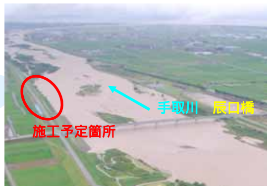
平成18年7月洪水状況
