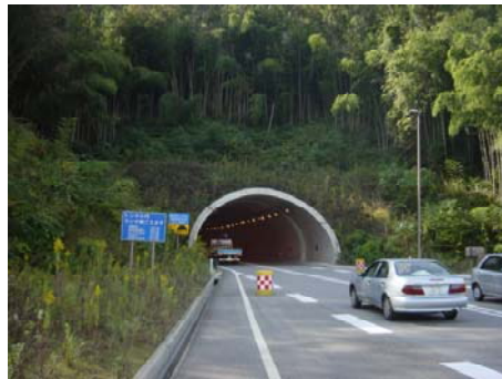
<神谷内トンネル>
