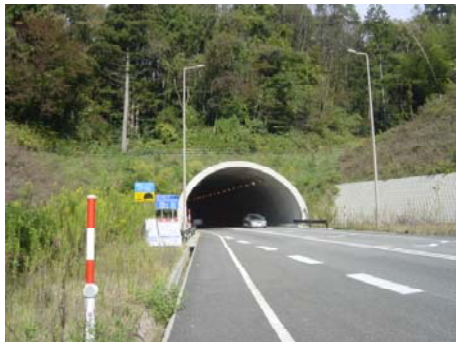
<御所トンネル>
