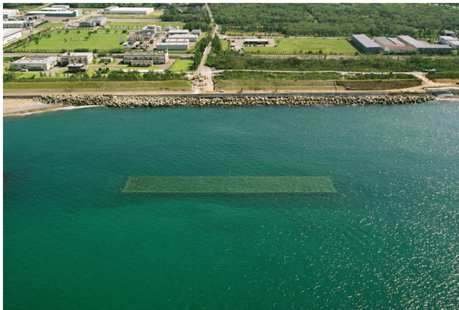
人工リーフ整備状況(海側から陸方向を斜め上空方向より望む)
