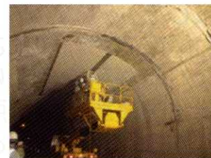
トンネル補修
